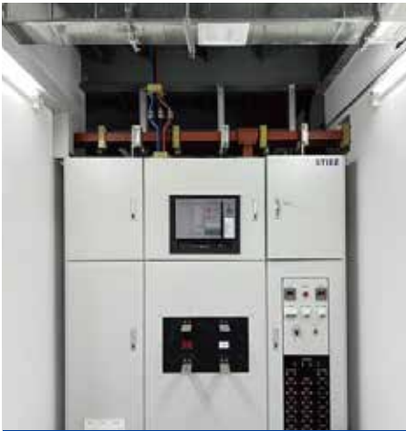
接通分断电寿命检测系统
